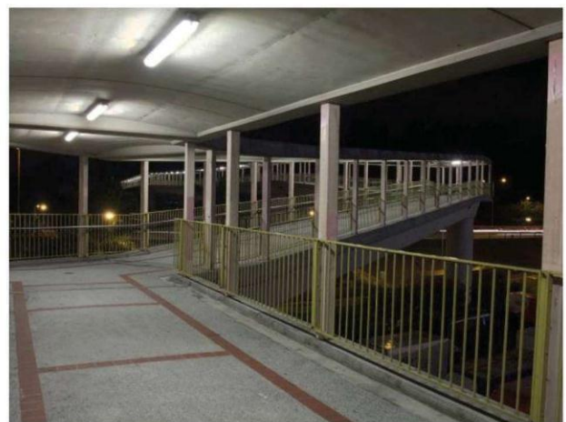
圖2：位於葵涌的天橋
